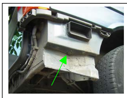
Vorh. Bohrung für Kabeldurchführung, von außen
