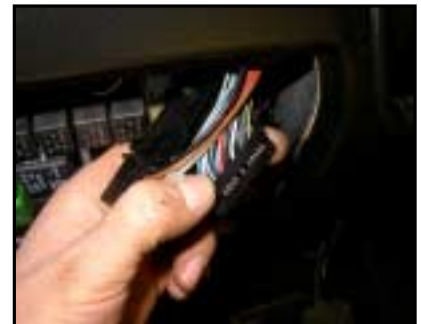
Anschluss des E-Satzes, Kontrollleuchtenkabel
