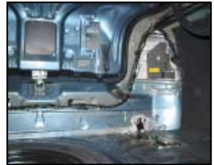
Anbau der AHK
